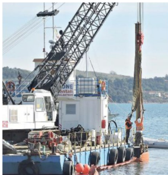
«CANTIERE» L'inizio delle operazioni nella giornata di ieri
