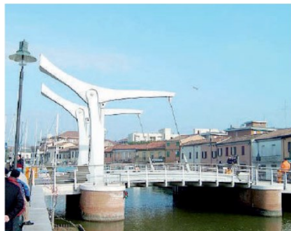
Il ponte mobile sul porto canale
