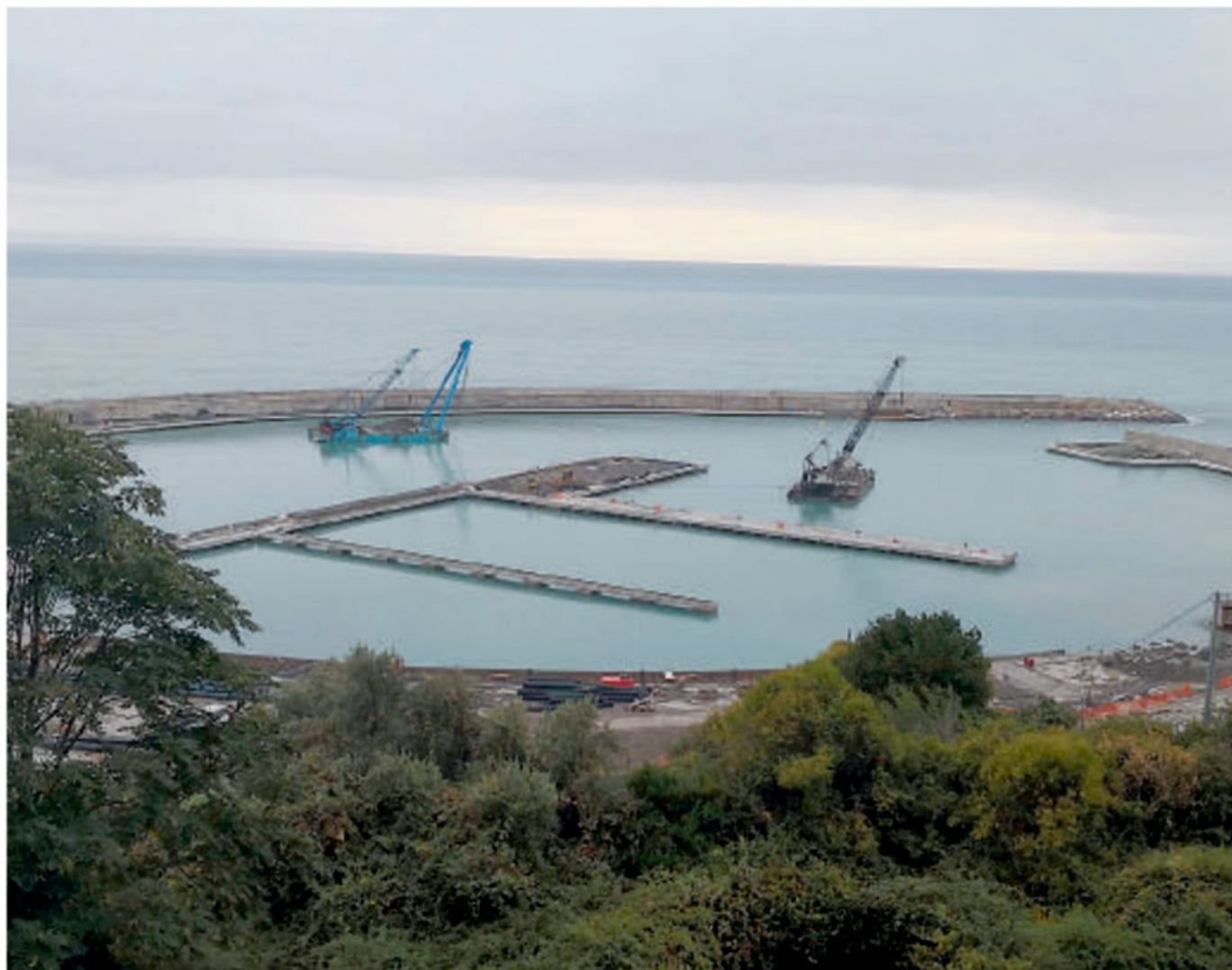
Una veduta del cantiere del porto degli Scoglietti a Ventimiglia
