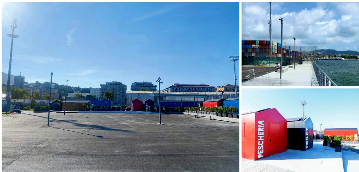
Qui sopra e a destra in alto due scorci del piazzale di Calata Paita nei giorni successivi all'inaugurazione. A destra alcune delle strutture installate per ospitare attività e servizi oggetto del bando che, dopo due flop, potrebbe forse trovare nelle prossime settimane un concessionario e quindi far scattare l'avvio vero del progetto congiunto Comune e Autorità Portuale.
