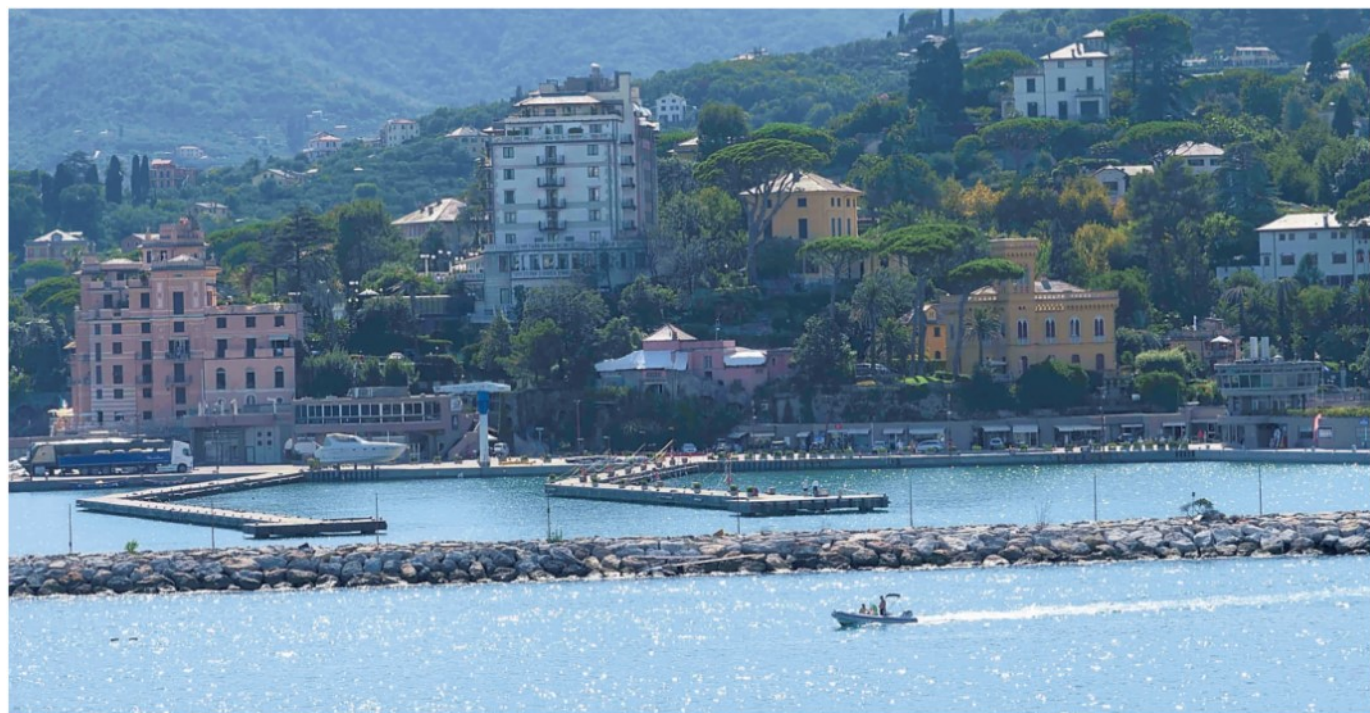
Il porto Carlo Riva di Rapallo. In alto due rendering di come diventerà dopo i lavori
